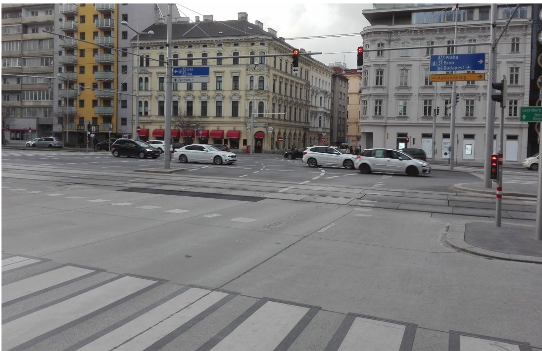
Negativbeispiel einer Kreuzung im Hauptradverkehrsnetz der Stadt Wien mit weiten Querungslängen für den Fußverkehr und wenig intuitiver Führung des Radverkehrs: Argentinierstraße # Wiedner Gürtel (4.) (Quelle: Johannes Roither)
