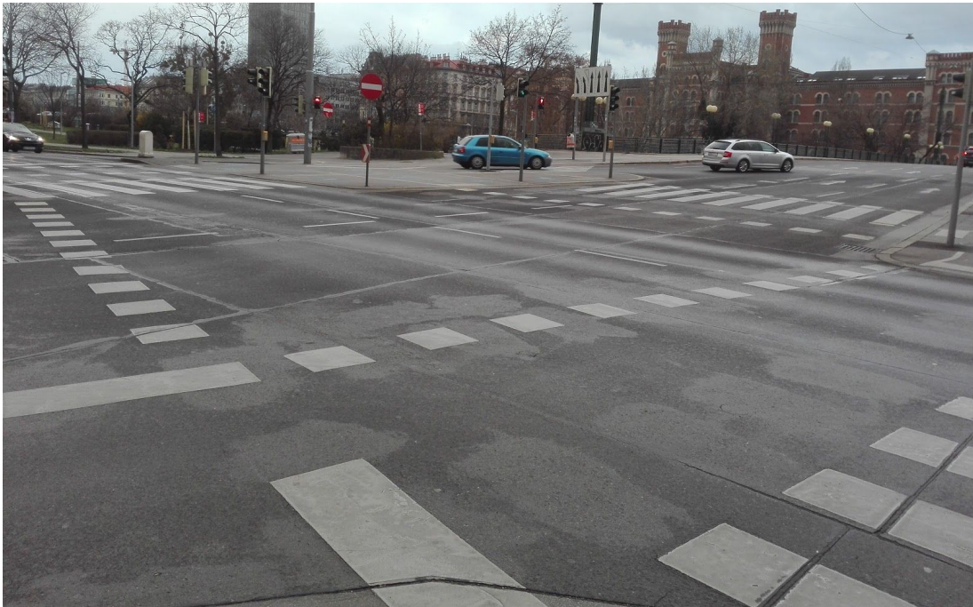
Negativbeispiel einer Kreuzung im Hauptradverkehrsnetz der Stadt Wien mit Mittelinsel und kaum Platz für den Fuß- und Radverkehr: Rossauer Brücke # Obere Donaustraße mit Lücke im Radwegenetz Obere Donaustraße (2.) (Quelle: Johannes Roither)
